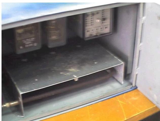
Рис. 2. Система стабилизации температур на основе ТЭНа
